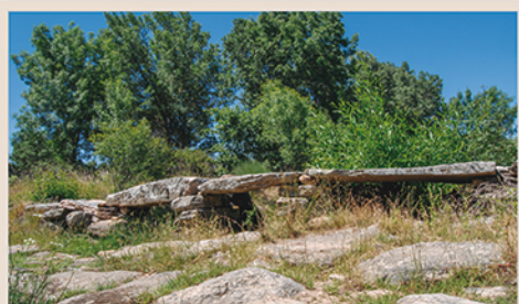
O caminho, passando sobre a ponte sobre a ribeira de Tourões. El sendero pasando por el puente sobre la ribeira de Tourões.
